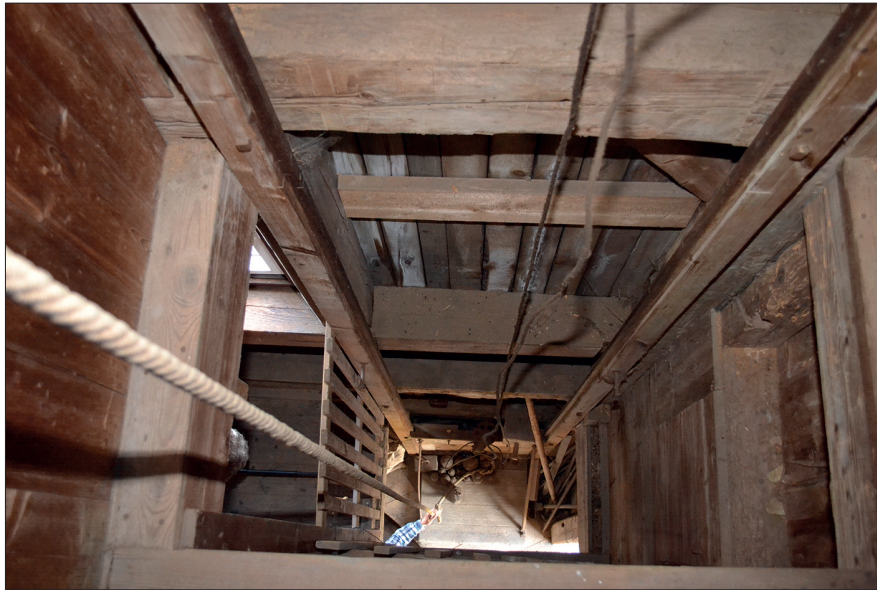
Fig. 8. Berndt-Mühle – an elevator in a post mill! (G. Hackney).
